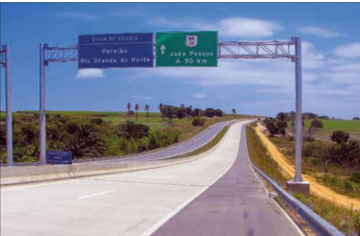
Vista da Rodovia 101 NE entre o Rio Grande do Norte e a Paraíba. Fonte: DNIT
